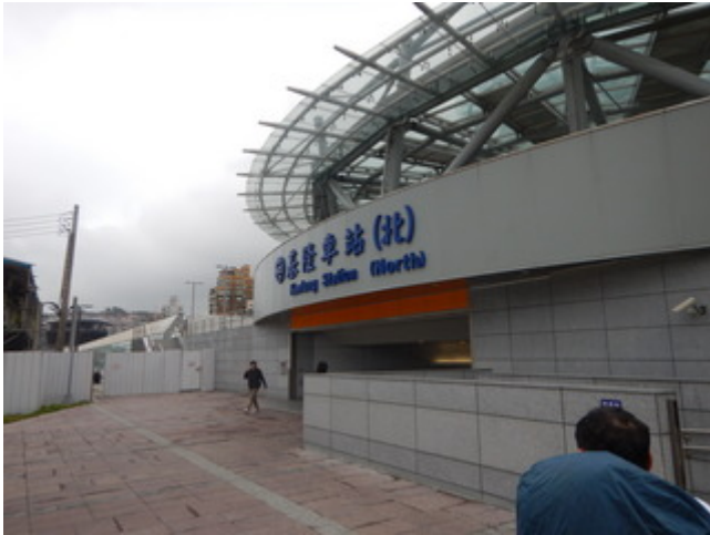
基隆駅北口 新駅舎
